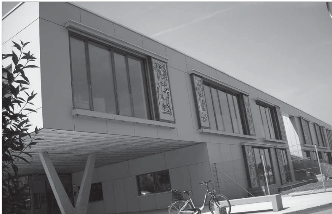
Der neu errichtete, barrierefreie Kindergarten in der Raimundstraße
